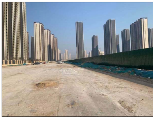
项目北侧现状（规划幸安西路）
