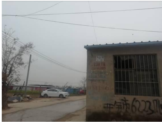
西岗村临时安置点
