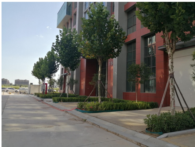
项目南侧 15 号楼
