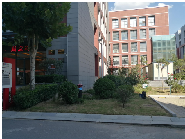
项目东南侧绿化及配电箱
