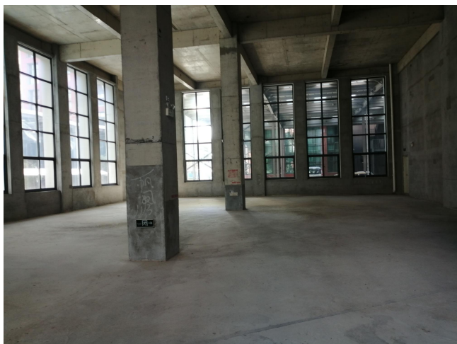
项目厂房内现状
