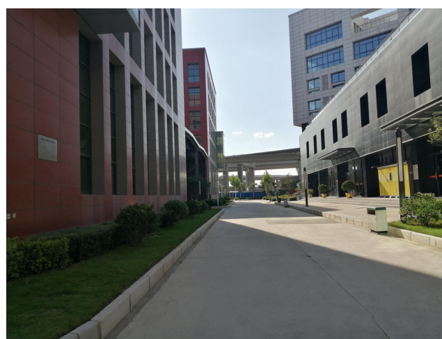
项目北侧园区道路
