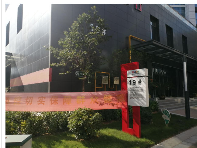
项目北侧 19 号楼
