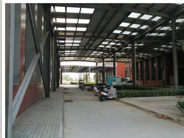
项目西侧园区道路
