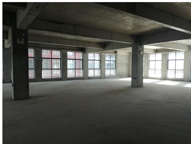
项目厂房内现状
