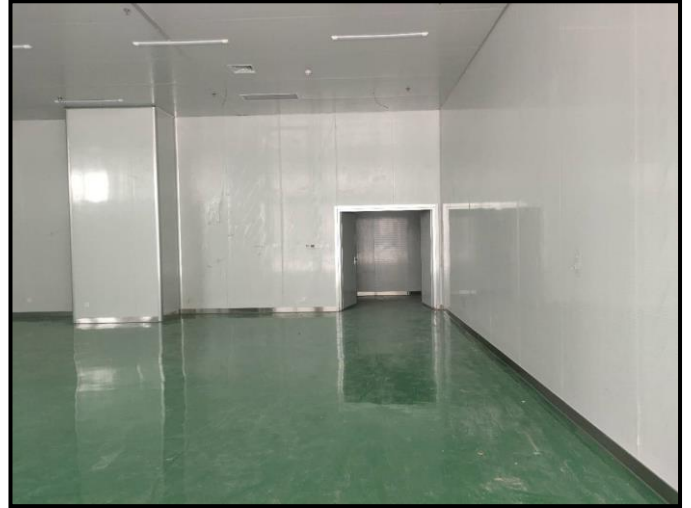
生产车间内现状
