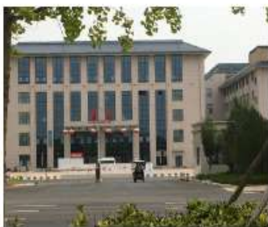
现有工程急诊楼
