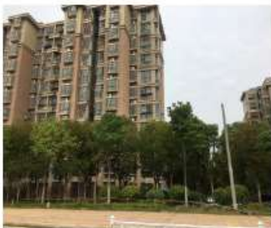
项目北侧恒源新城小区
