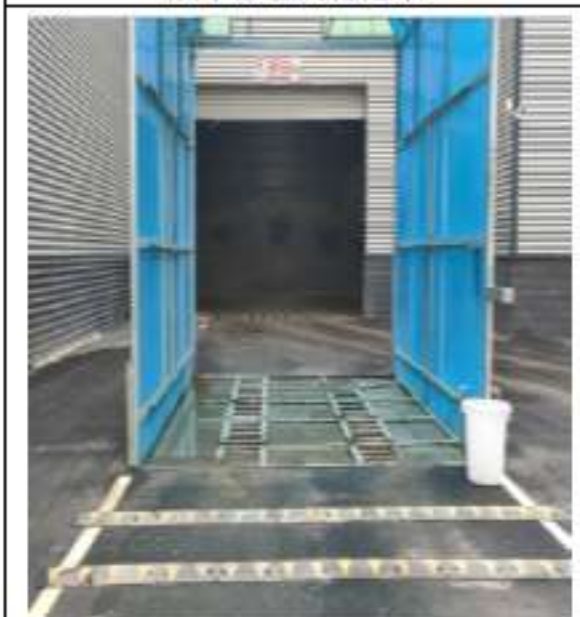
商混进出料仓车辆冲洗
