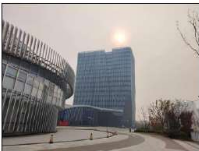
生物医药科技园 B 区 1#楼
