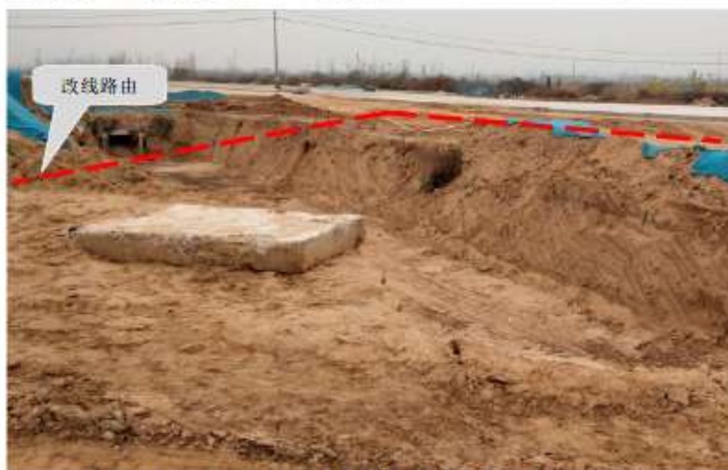
图 3.2-1 顶管穿越滨河西路人行道及辅道（滨河西路正在施工）
