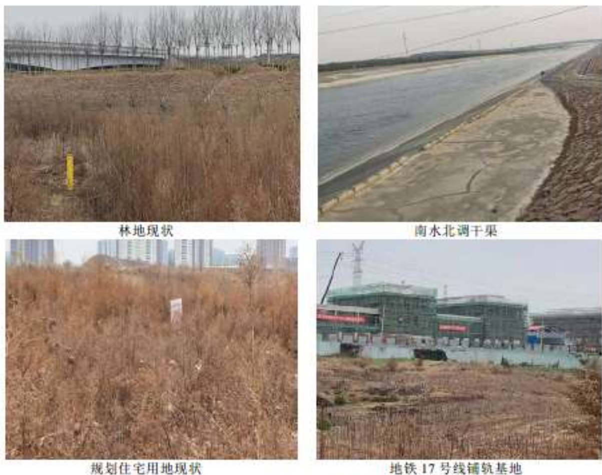
图 4.4-1 本项目管线两侧用地现状
