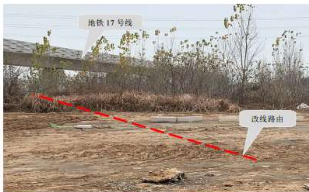
图 3.2-2 地铁 17 号线桥下穿越
