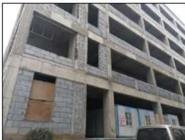
项目西侧空置厂房
