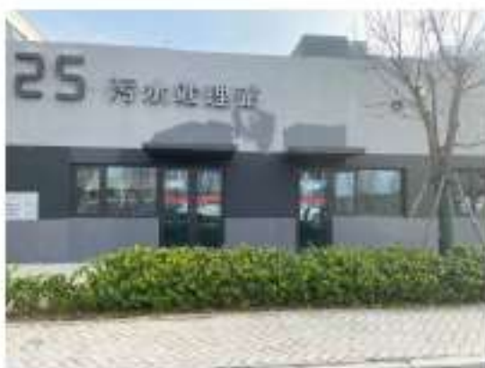
园区污水处理站
