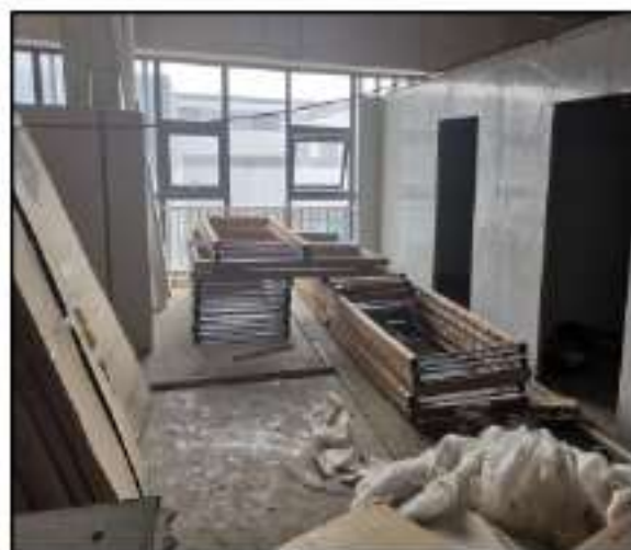
项目基础装修现场照片
