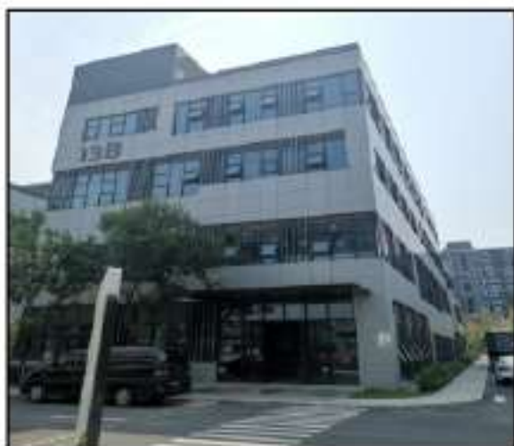
13 号楼 B 栋外观
