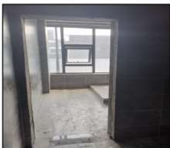
项目基础装修现场照片
