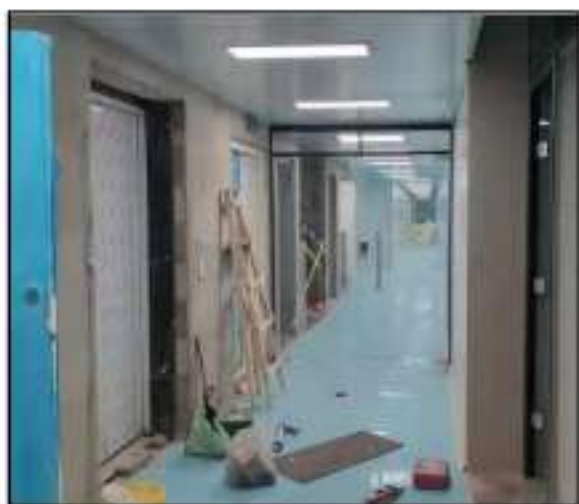
项目基础装修现场照片
