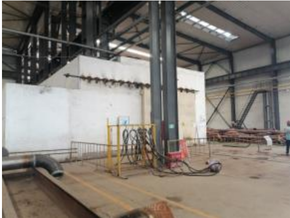
探伤室东侧（生产厂房内）
