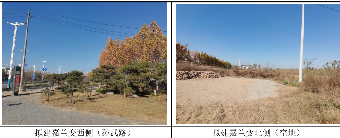
图 2-2 新建嘉兰 110kV 变电站站址现状照片
