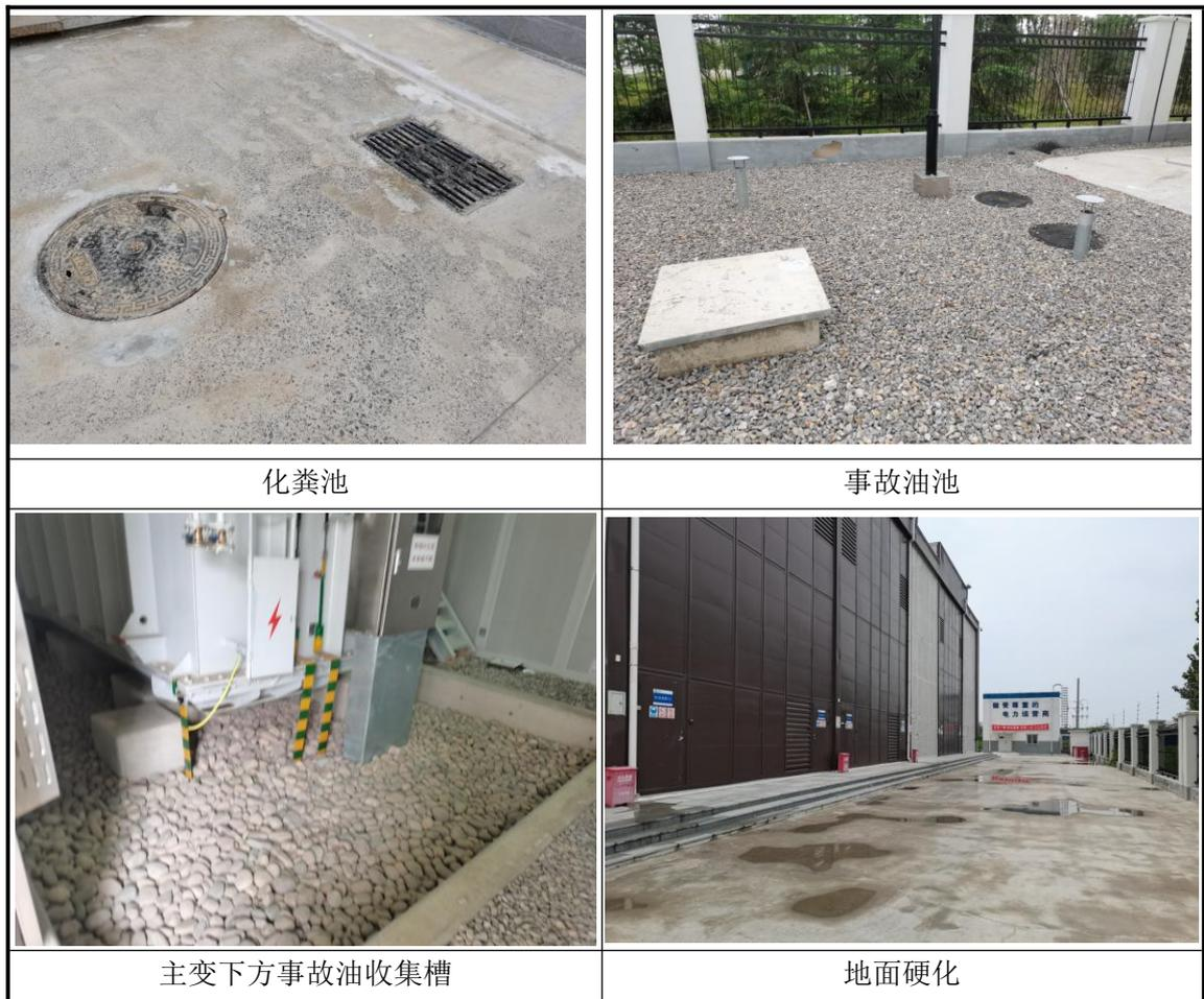
图 2-3 钟观 110kV 变电站原有环保设施照片
