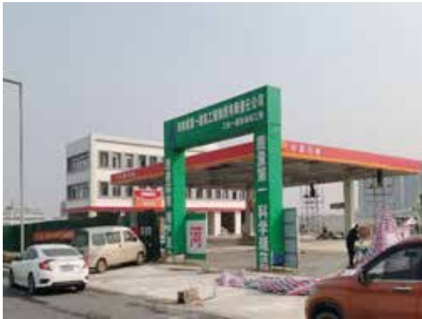
项目西北侧工业一路加油站（在建）
