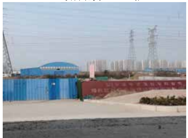
项目北侧中铁项目部
