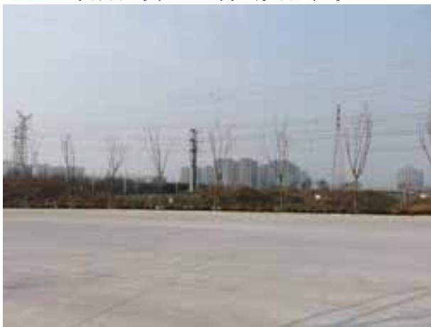
项目南侧黄海路
