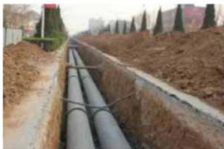
图 6：热水管道管沟内敷设示意图
