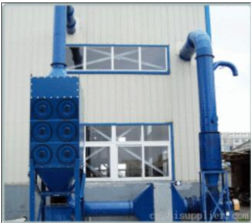
图 5.3-3 弹匣式除尘器示意图
