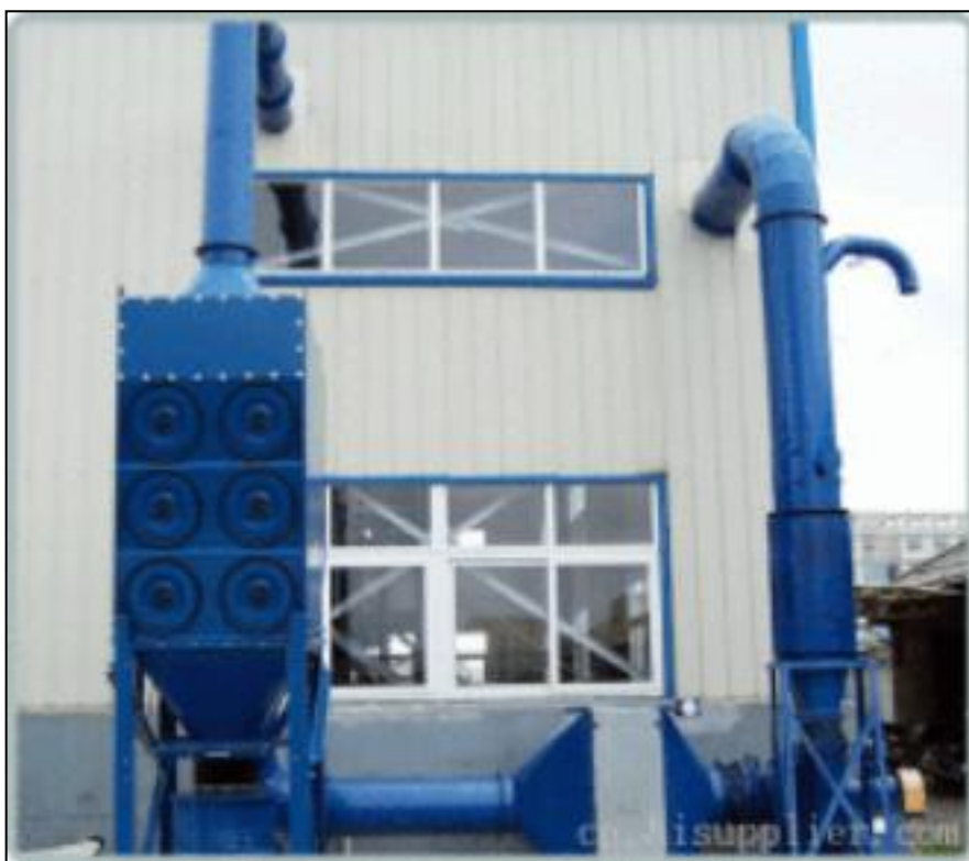
图 5.3-3 弹匣式除尘器示意图
