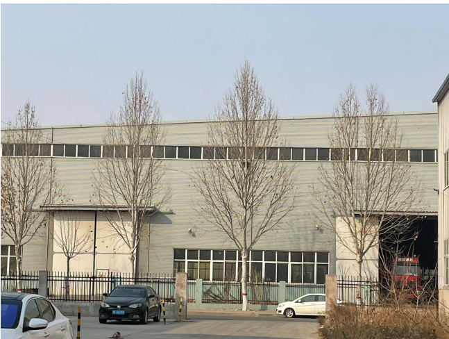
本项目北侧钢板加工厂
