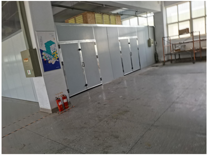
拟建喷漆、烘干室现状照片
