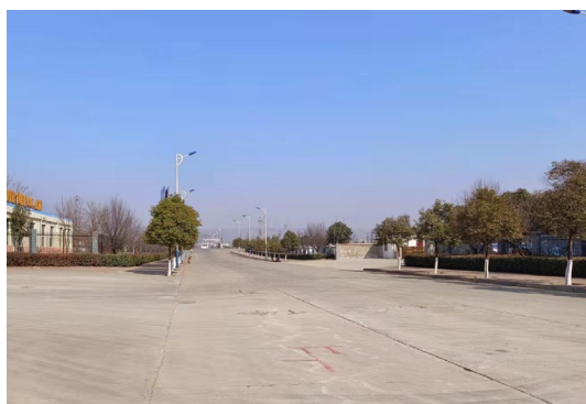
照片 2-2 道路建设
