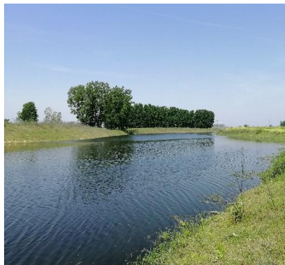
现场照片 2-3 瀝河已治理河道
