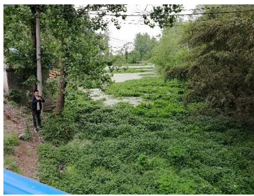
照片 2-41 泥河河道淤堵
