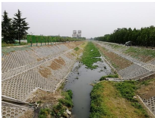
现场照片 2-4 三里沟治理工程
