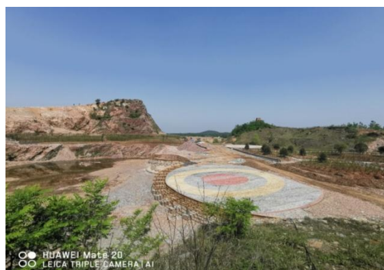
照片 2-7 正在施工中的火石山矿山公园
