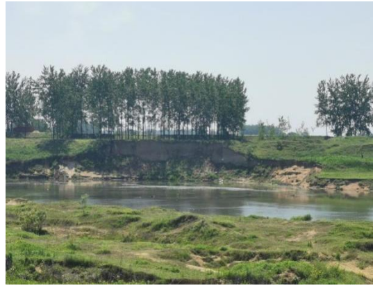
照片 2-34 沙滩 HH04 南岸坍塌
