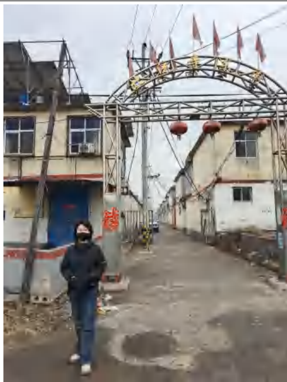
现场踏勘照片
