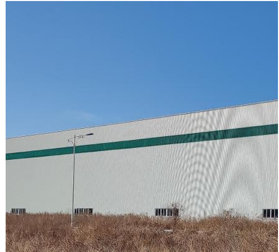
西侧-安钢集团冷轧有限责任公司电磁新材料 一期工程
