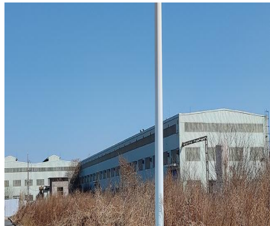
北侧-安钢集团冷轧有限责任公司厂房
