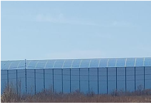
南侧-安钢集团冷轧有限责任公司厂房
