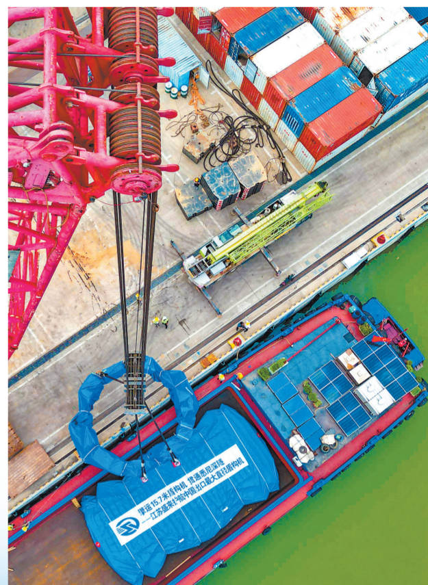
7月8日,周口港,工人正把超大型盾构组件吊运到船舱。
