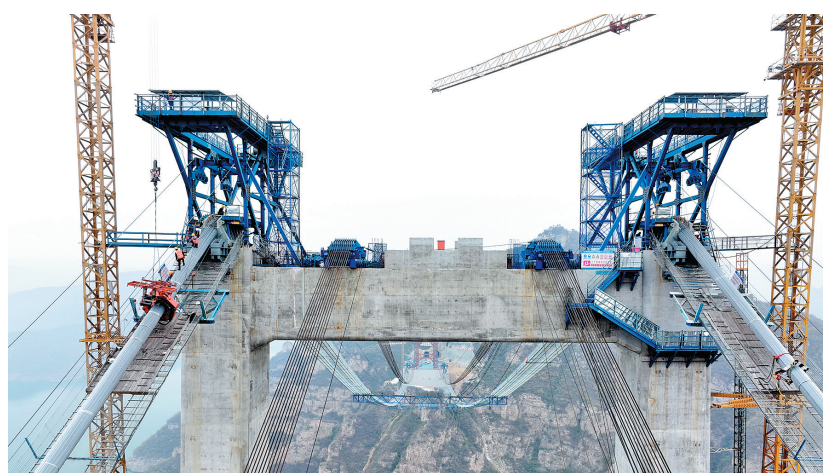
2024年11月8日,中铁四局工人在黄河三峡大桥施工现场安装紧缆机。
