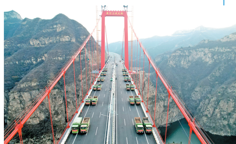
2025年12月5日,黄河三峡大桥顺利完成荷载试验。
