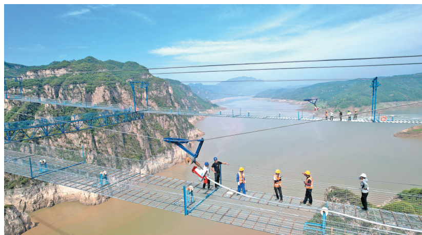
2024年7月6日,中铁四局工人在黄河三峡大桥工地进行主缆架设。
