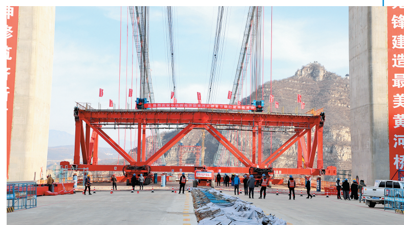
2025年2月14日,黄河三峡大桥首节钢桁梁吊装成功。
