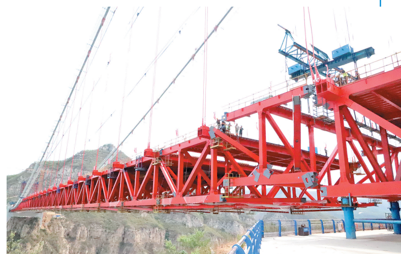
2025年6月10日,黄河三峡大桥钢桁梁吊装完成。
