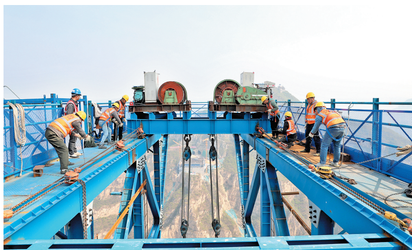
2024年4月6日,中铁四局工人在黄河三峡大桥工地进行主索鞍吊装。
