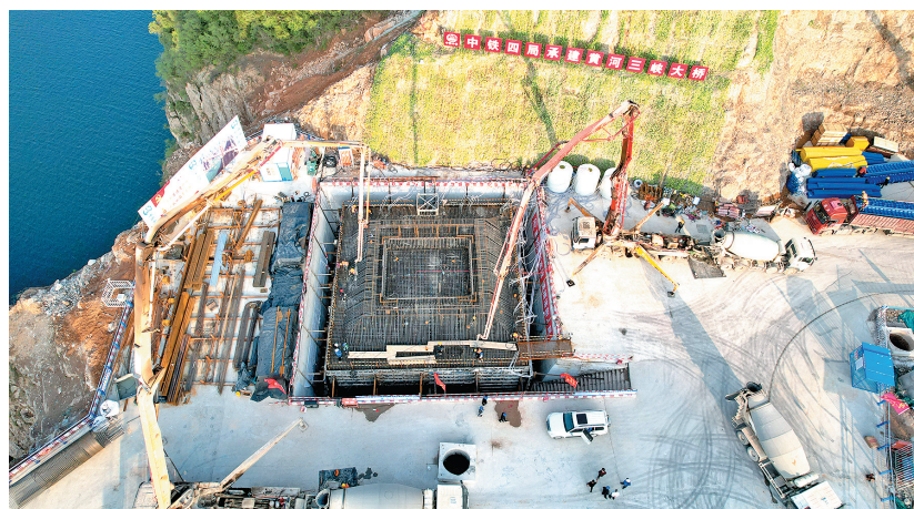
2023年4月25日,中铁四局工人在黄河三峡大桥工地进行承台浇注作业。
